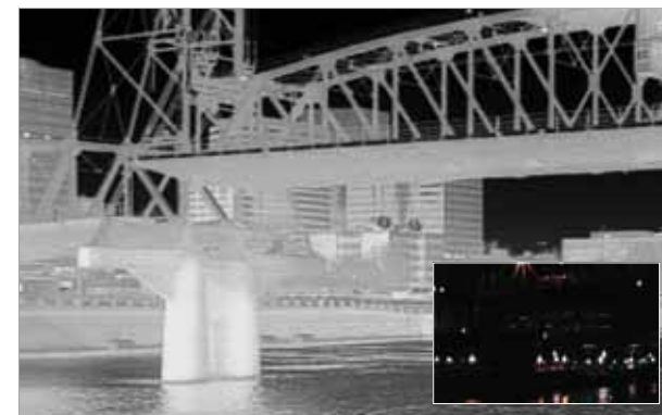
Termisk bild över brofundament och motsvarande bild vad ögat ser
